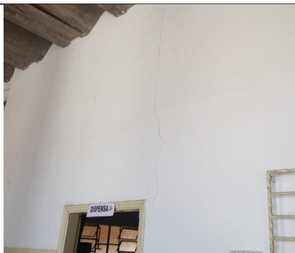
Rachadura na parede do refeitório
