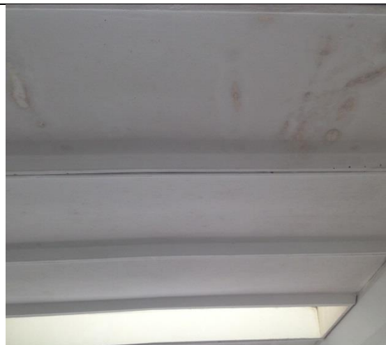
Infiltração no teto da sala de Leitura/ Biblioteca
