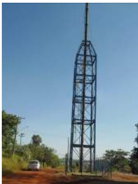
FIGURA 102. Stand Pipe na Adutora de Água Bruta.
