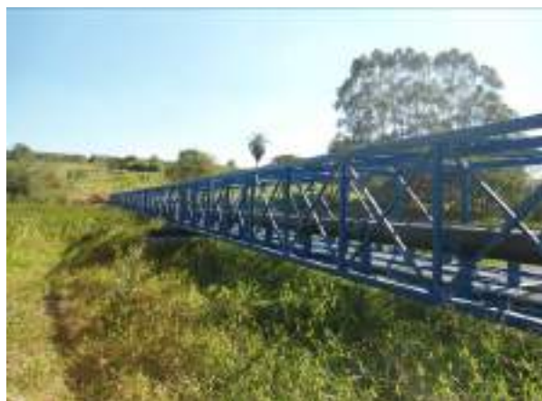
FIGURA 101. Travessia da Adutora de Água Bruta .
